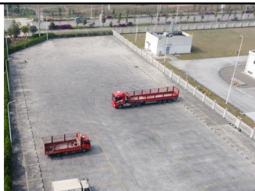
东侧停车场地坪硬化
